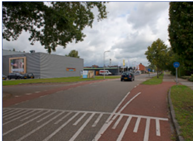
Demmersdwarsweg en wegversmalling bij Groothuis Timmerfabriek (2)
